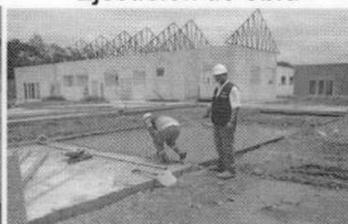
Vaciado de concreto en zona de estacionamiento y colocación de tijaeras
