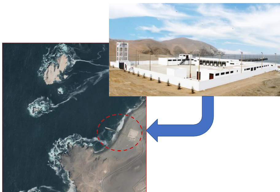
Figura N° 22: DPA Bahía Blanca, protegido de por la geografía (abrigo natural)
