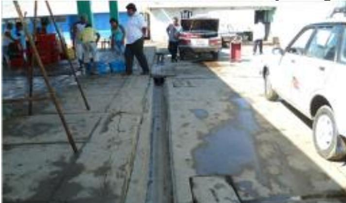
No se realiza tratamiento de efluentes de la sala de lavado, por lo que se presentan obstrucciones debido a la falta de trampas de sólidos y sedimentadores.
