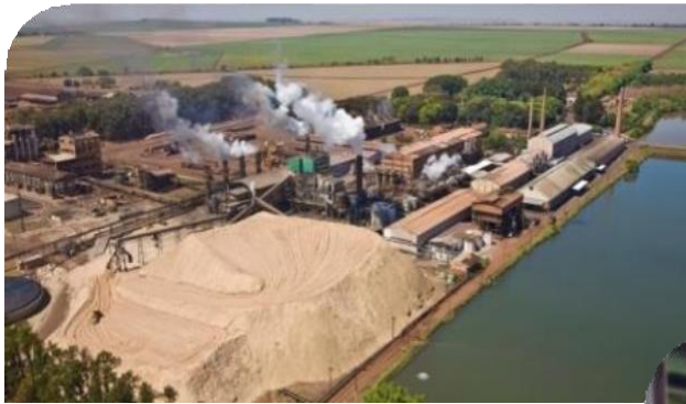
Patio de bagazo
